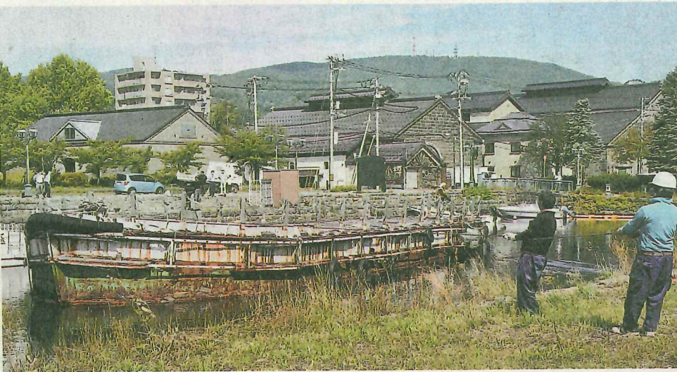
撤去作業が始まった小樽に現存する最後のはしけ
